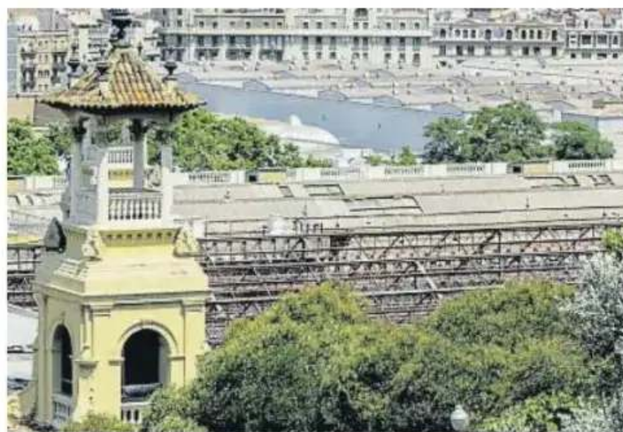
La cubierta de amianto del palacio Alfonso XIII está siendo retirada
