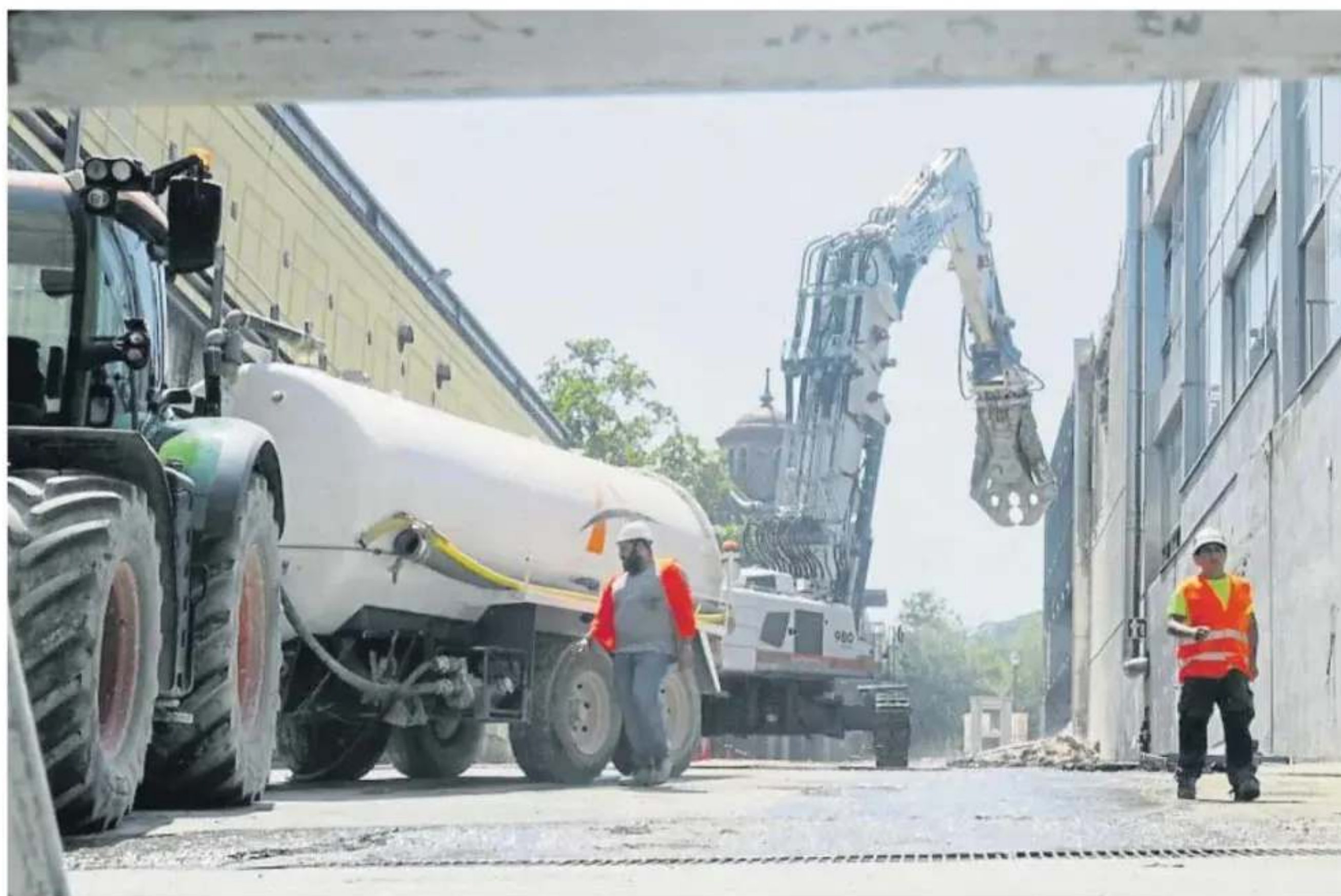
La grúa de grandes dimensiones inició ayer por la mañana las tareas de demolición en el exterior del palacio 4 de Montjuïc
